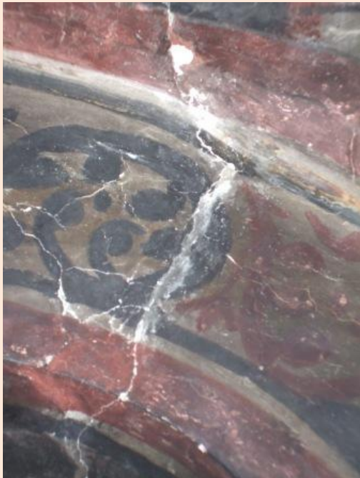
Fisură în timpanul dintre pronaos și naos, chituită la restaurarea picturii din anii 1986-1989
