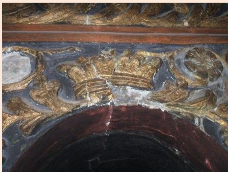
Fisură în timpanul dintre naos și altar, cu desplasarea puternică a celor două părți, chituită la restaurarea picturii din anii 1986-1989
