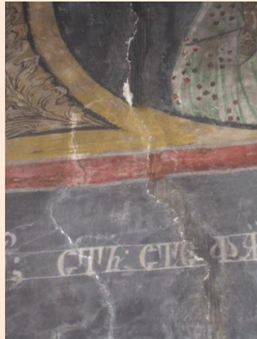
Fisură în timpanul dintre pronaos și naos, chituită la restaurarea picturii din anii 1986-1989
